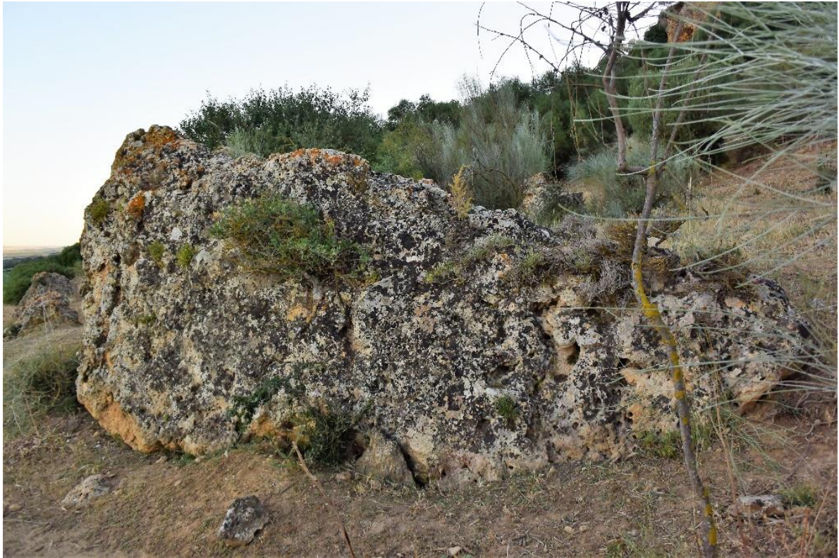
Fig. 24. Estructura 2. Lado Este. Alcanza una altura cercana a los 3 metros
